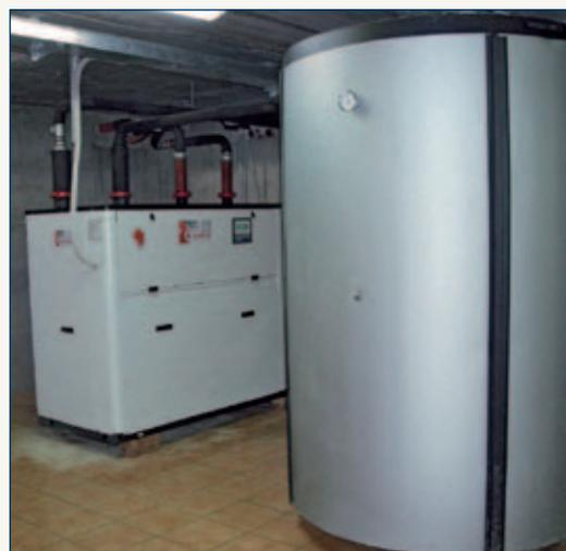
*Soluzione per edilizia commerciale con scambio geotermico integrazione con più fonti energetiche per produzione di calore e di acqua sanitaria e di raffrescamento*
