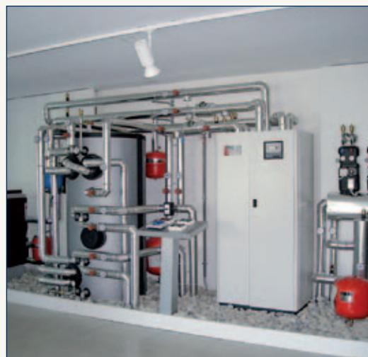
*Soluzione per edilizia residenziale monofamiliare con scambio geotermico integrazione con più fonti energetiche per produzione di calore e di acqua sanitaria e raffrescamento free-cooling*
