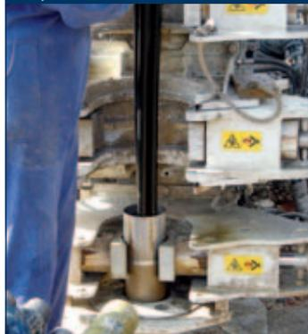
*Macchina per trivellazione operante con doppia testa per foratura in camicia*
